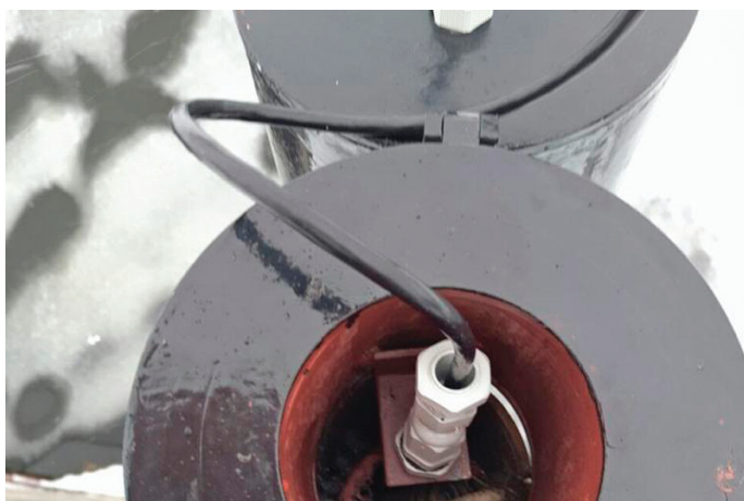
Рис. 3. Монтаж измерительного комплекта внутри скважины
