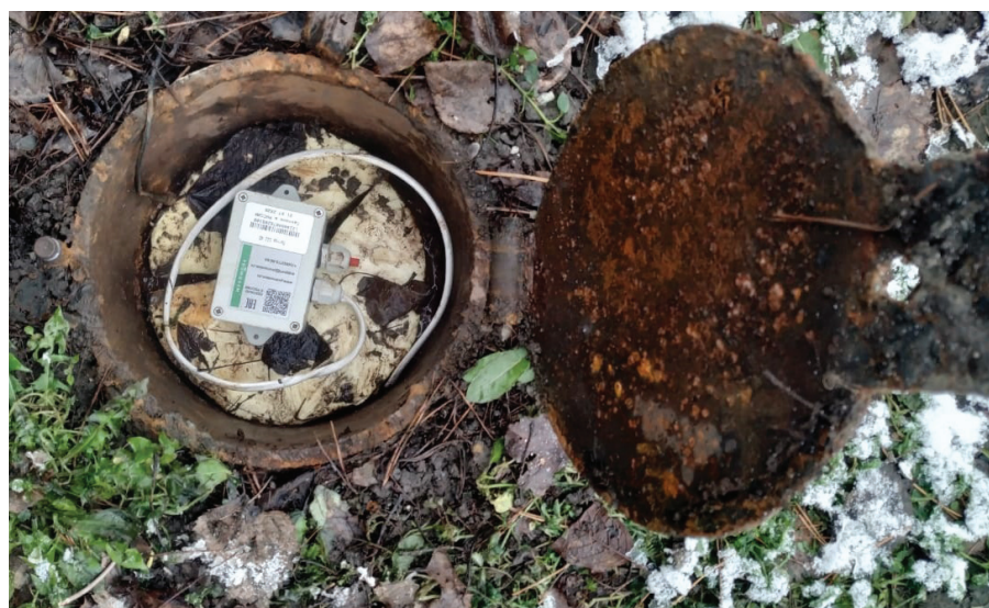
Рис. 8. Выносной узел контроля затопления тепловой камеры на базе комплекта «Датчик вскрытия люка и уровня-протечки PROMODEM GSM 830.04»
